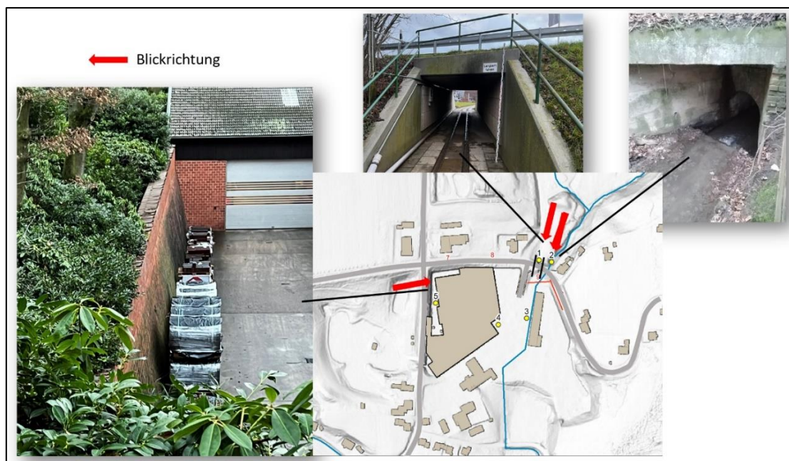
Abbildung 56: Verschiedene Blicke auf das Betriebsgelände sowie auf die Randbedingungen des umgebenden Geländes
