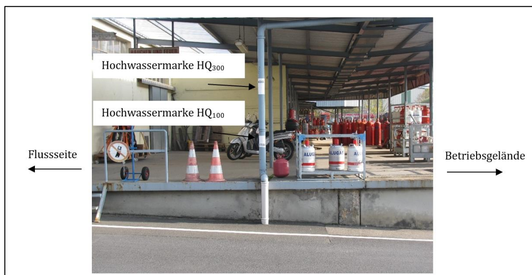
Abbildung 79: Hochwassermarken für ein HQ 100 und ein HQ 300 im Eingangsbereich zum Betriebsgelände
